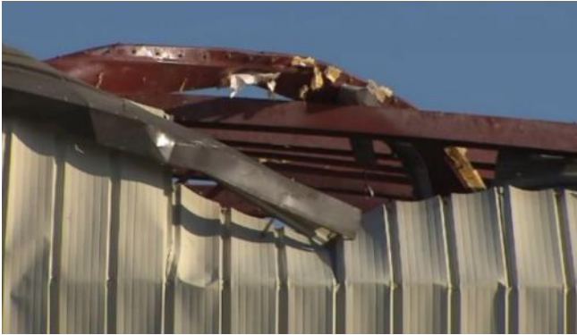
(d) Exposed metal framing
